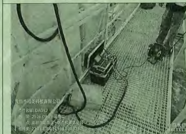
DA012 3 号铬酸雾废气排放监测口 (12"◎)
