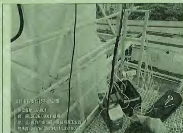
DA001 1号酸性废气排放监测口 (1#◎)
