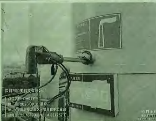
DA017 5 号铬酸雾废气监测口 (17"◎)
