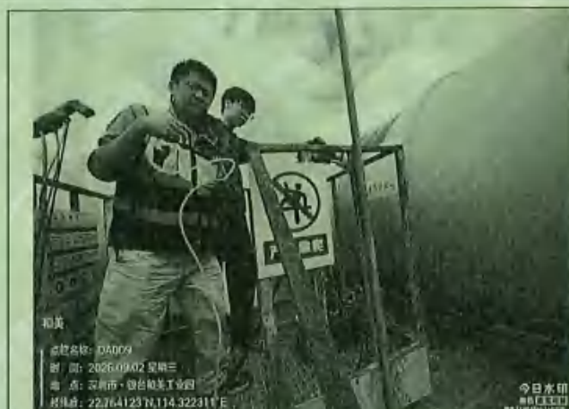
DA009 6 号酸性废气排放监测口 (9"◎)
